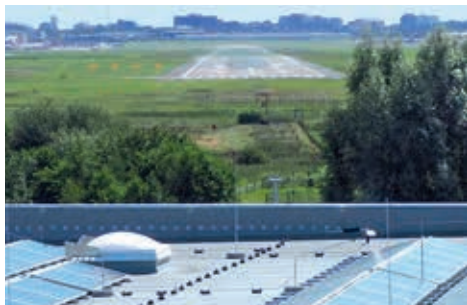
Photovoltaik-Anlage mit Blick auf den Hamburger Flughafen
